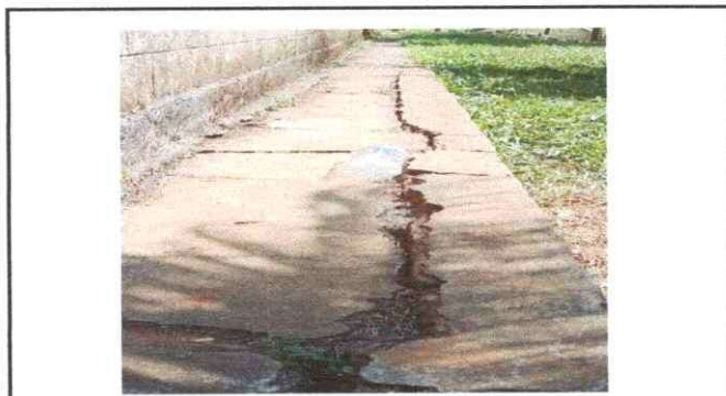
Foto 3: cambio de piso interior y exterior.
