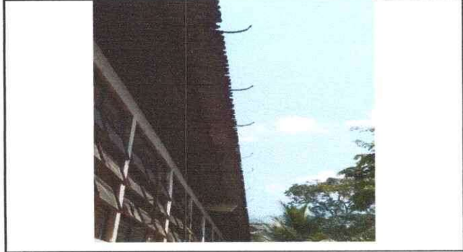
Foto 2: Implementación de canales y bajadas de agua pluvial
