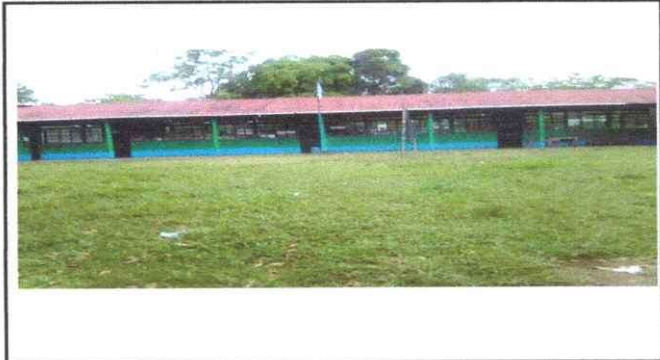
Foto1: Cubierta de lámina
