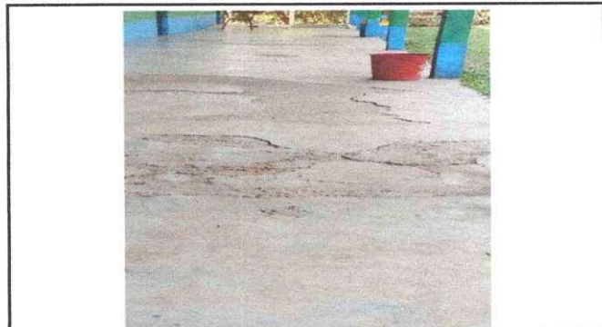
Foto 4: cambio de piso interior y exterior
