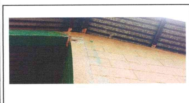
Foto 5: Cambio de cubierta de lámina
